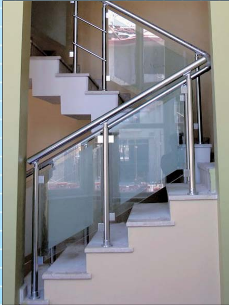
Camlı merdiven uygulaması
