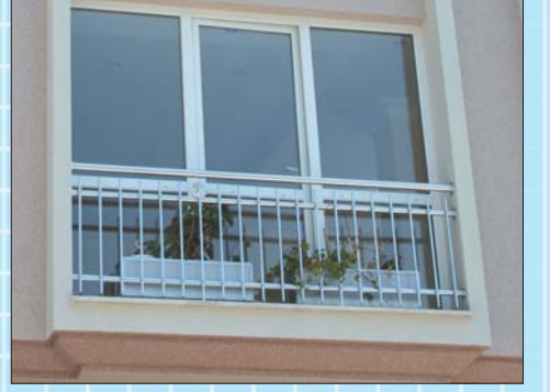
Dikey şeritli fransız balkon küpeşte uygulaması
