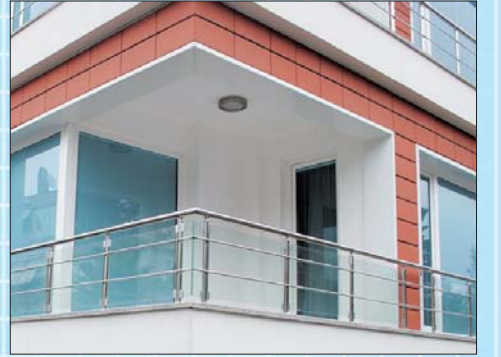
Mermer üstü balkon küpeşte uygulaması
