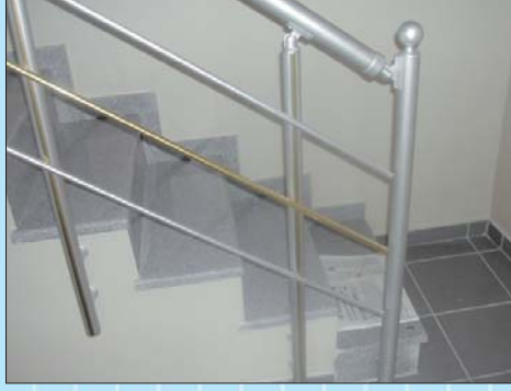
Yandan ankrajlı merdiven küpeşte uygulaması
