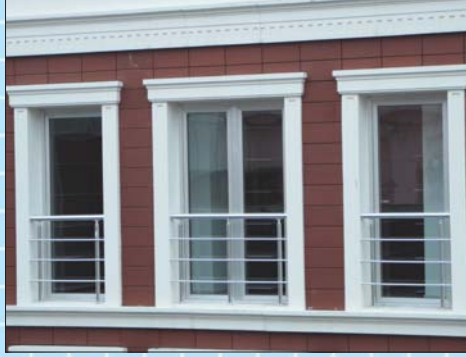
Yatay şeritli fransız balkon küpeşte uygulaması
