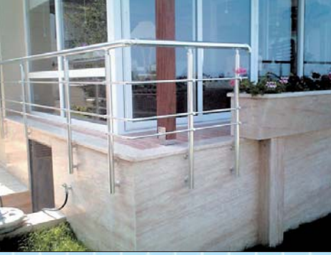
Dıştan bağlantı balkon küpeşte uygulaması
